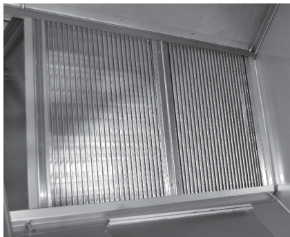
Пластинчатый рекуператор (рис. 12)
